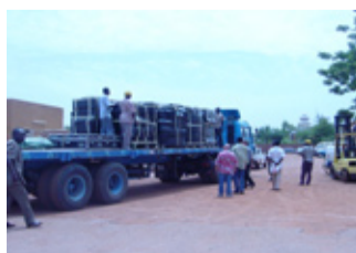
INSTALLATION DU MATÉRIEL ET FORMATION DE L'ÉQUIPE TECHNIQUE 2004
