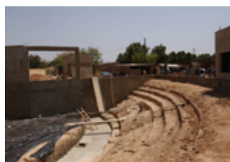
CHANTIER DU REEMDOOGO 2002/2003
